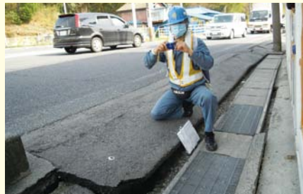
福島県内の国道被害調査支援
