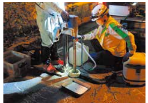
アスファルト舗装劣化に関する研究（令和4年）
