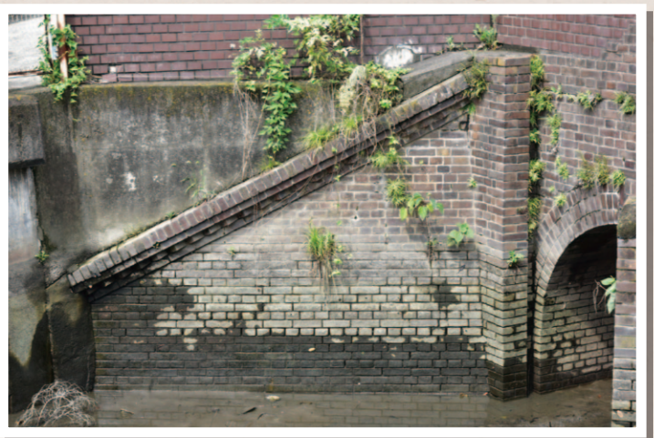
大口逆除の兩岸側には頂上を保護するための笠石(かさいし)が4段積みで施されている
