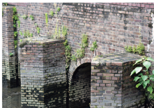
五角形の柱と胸壁の間にある窪みを「角落(かくおとし)」という。この窪みに板(ゲート)をはめ込み、上げ下げする。また柱の先頭部分は石材を使うことが多いが、大口逆除はすべて煉瓦を用いている
